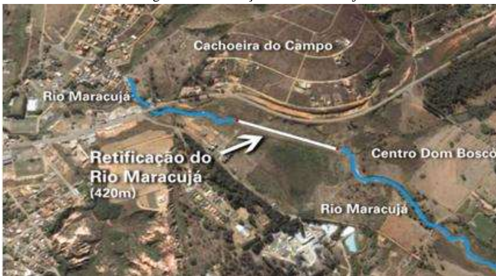
Figura 3 - Retificação do rio Maracujá
