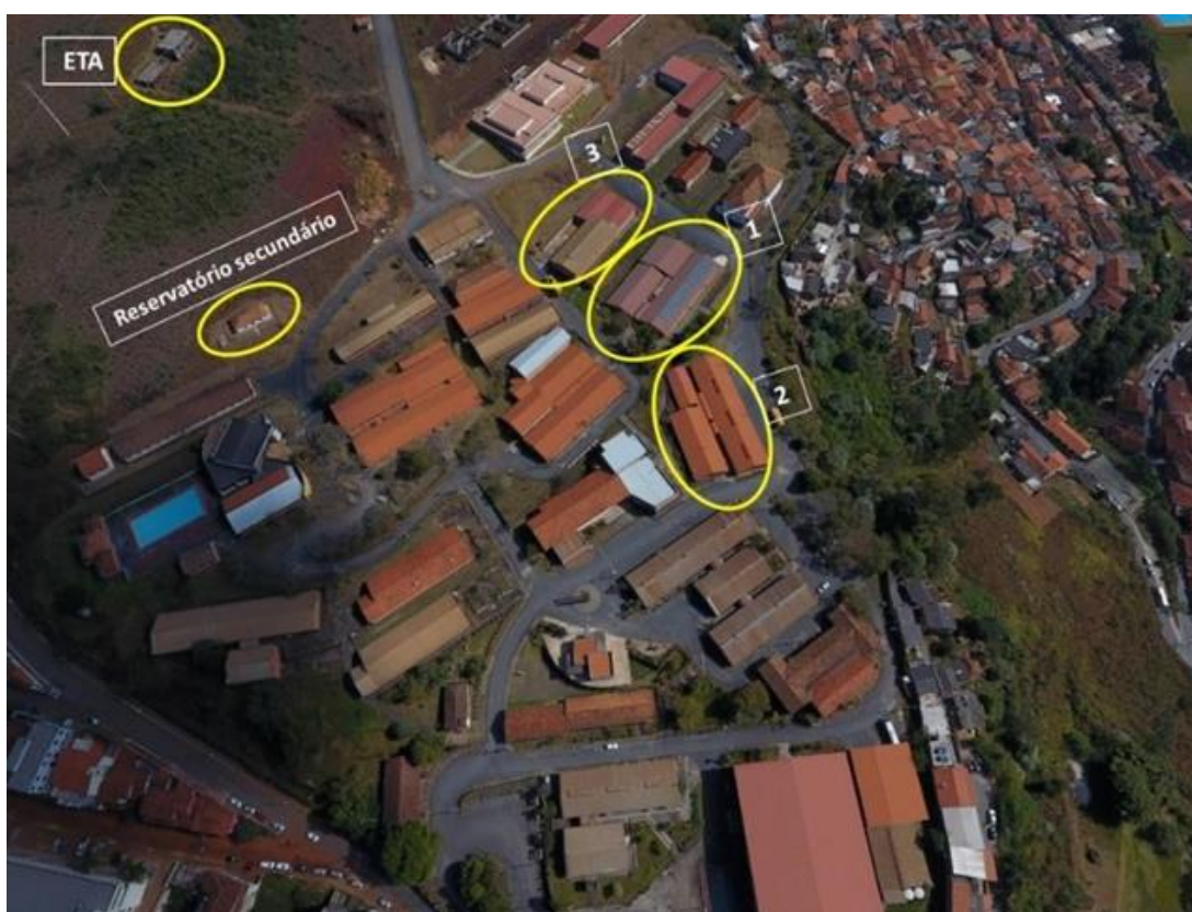
Figura 1. Vista aérea das edificações utilizadas neste estudo.
