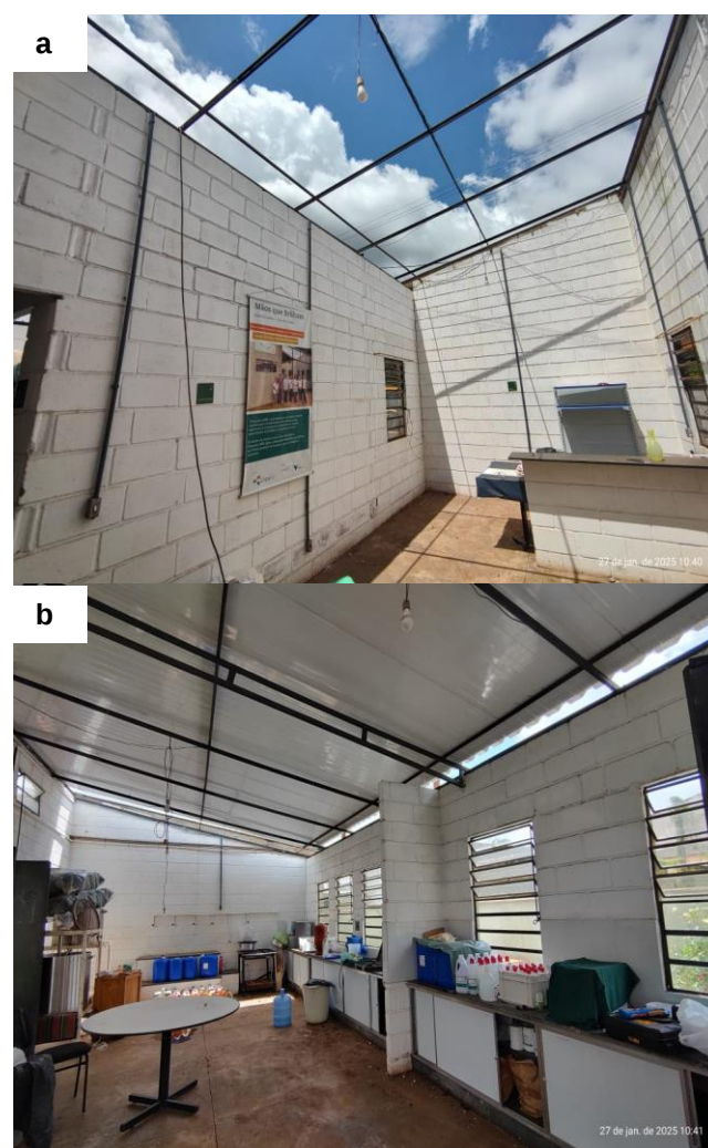
Figura 5. Telhado da sede da Associação Mãos que Brilham: (a) antes, e (b) depois da reforma.
