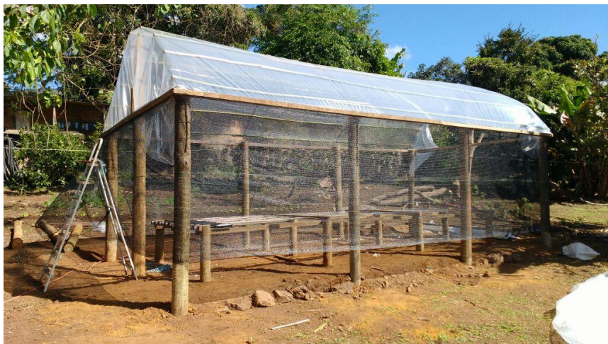
Figura 2. Construção da estufa
