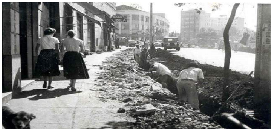
Figura 10 - Obras de Saneamento na Av. Paraná. 06/08/1957. Oswaldo Leite. Acervo do Museu Histórico de Londrina.
