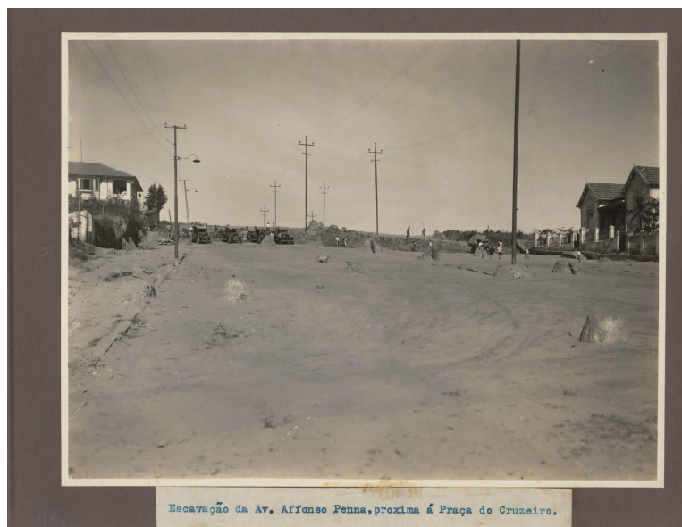
Escavação da Avenida Afonso Pena, próxima à Praça do Cruzeiro.
