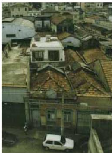
Fig. 2 - Vista aérea da casa 36 – na Rua Pedro Ernesto – Gamboa – Rio de Janeiro
