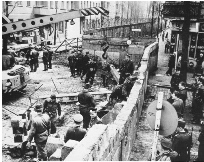
Figura 11. Construção muro de Berim, 1961.
